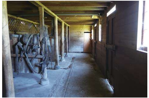
25b 同馬小屋内部
