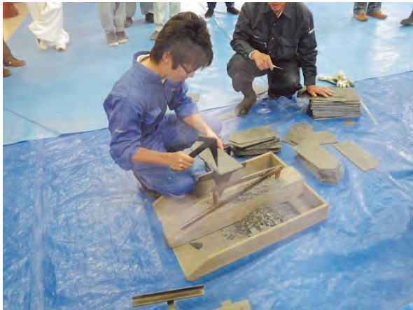
09 屋根葺き・先の尖った専用の工具で釘を打つ穴をあける
