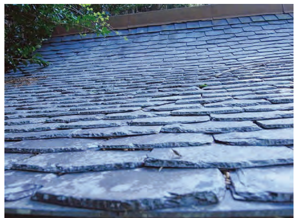
12 スレート屋根の完成
