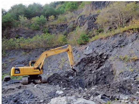
02 採石・表面の風化した石を除けると質の良い石が現れる
