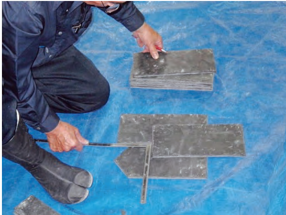
07 屋根葺き・パターンを考えながらスレートの形を決めていく
