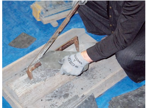
08 屋根葺き・押切で石を削ってスレートの形を整える
