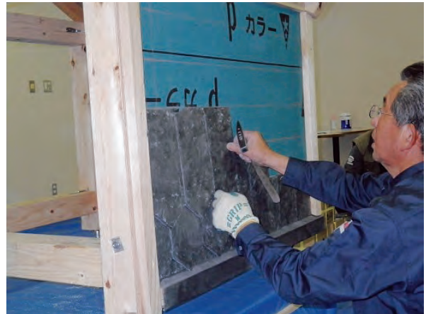
10 屋根葺き・色味の合うスレートを選りながら釘で打ちつけていく
