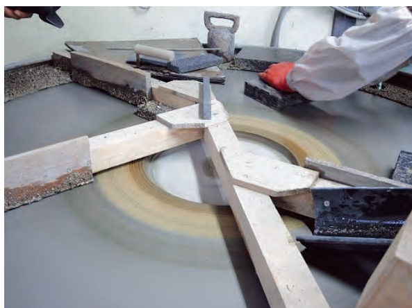
05 水と砂をかけながら、石の表面を平滑に研磨していく
